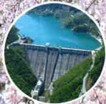
浦山ダム内部ウォーク
